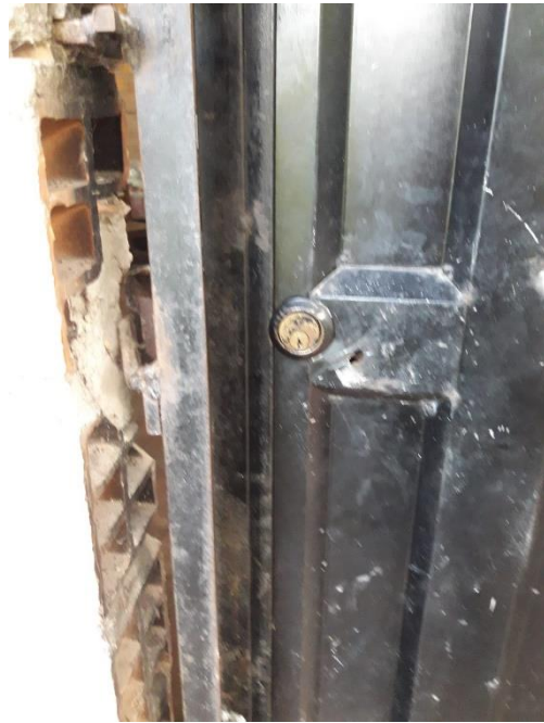
Puerta de ingreso a la sala de cómputo de la I.E.
