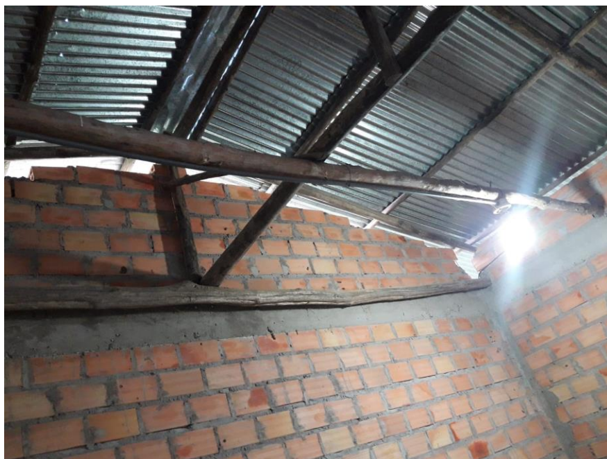
Parte del techo de la sala de cómputo de la I.E.
