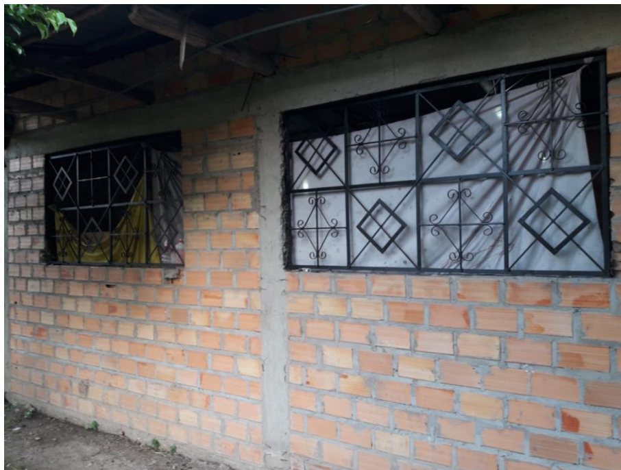
Ventanas de la sala de cómputo de la I.E.
