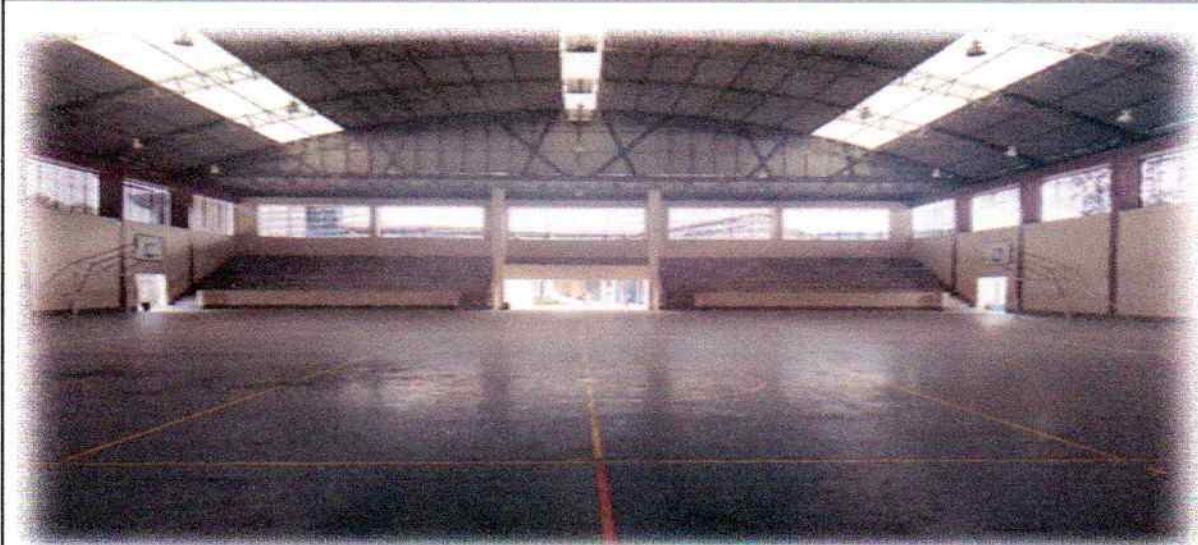
FOTO N° 05: EDIFICACION / PABELLON / AREA 1 - (Foto Interna 1)
