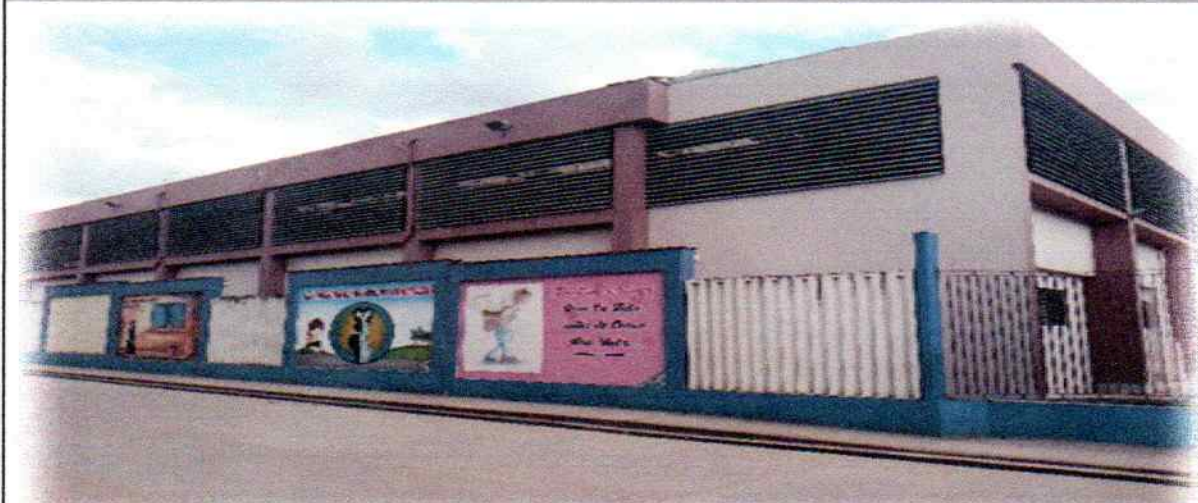
FOTO N° 04: EDIFICACION / PABELLON / AREA 1 - (Foto Externa)
