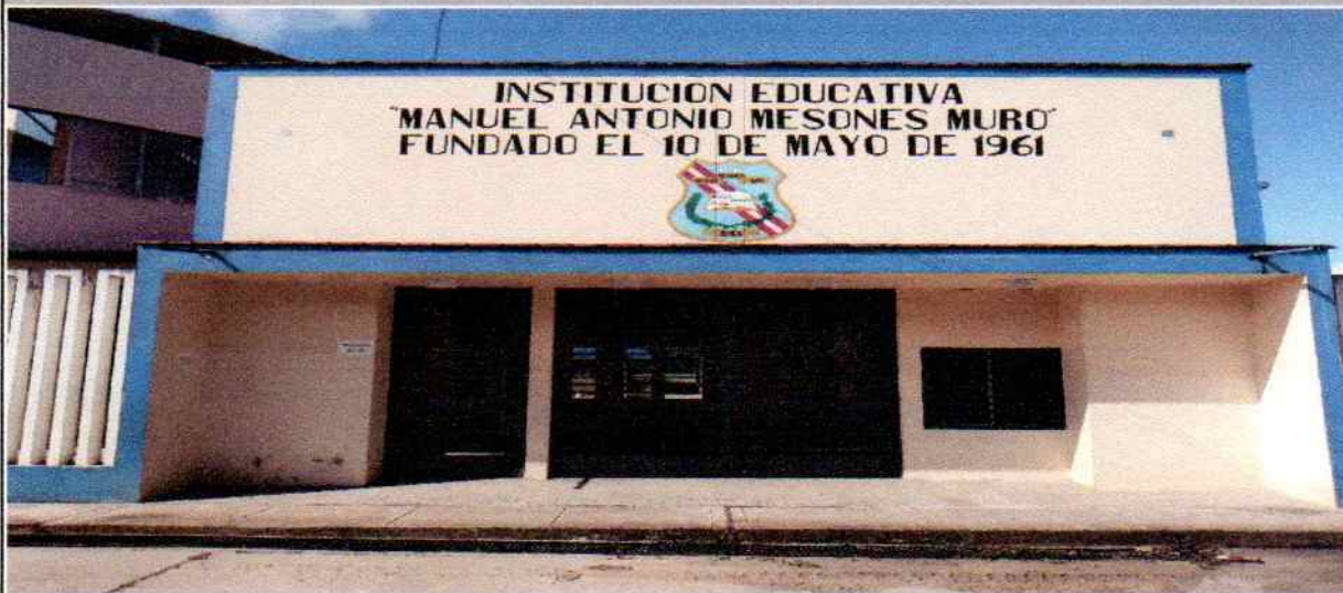
2) FOTO N° 02: VISTA PANORAMICA GENERAL 1
