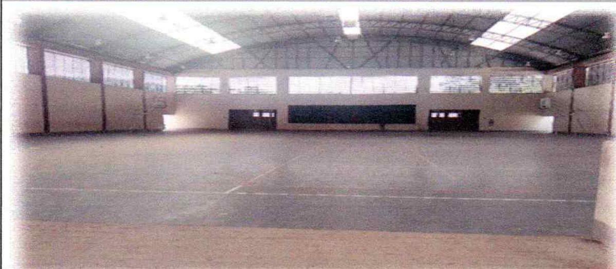
FOTO N° 06: EDIFICACION / PABELLON / AREA 1 - (Foto Interna 2)
