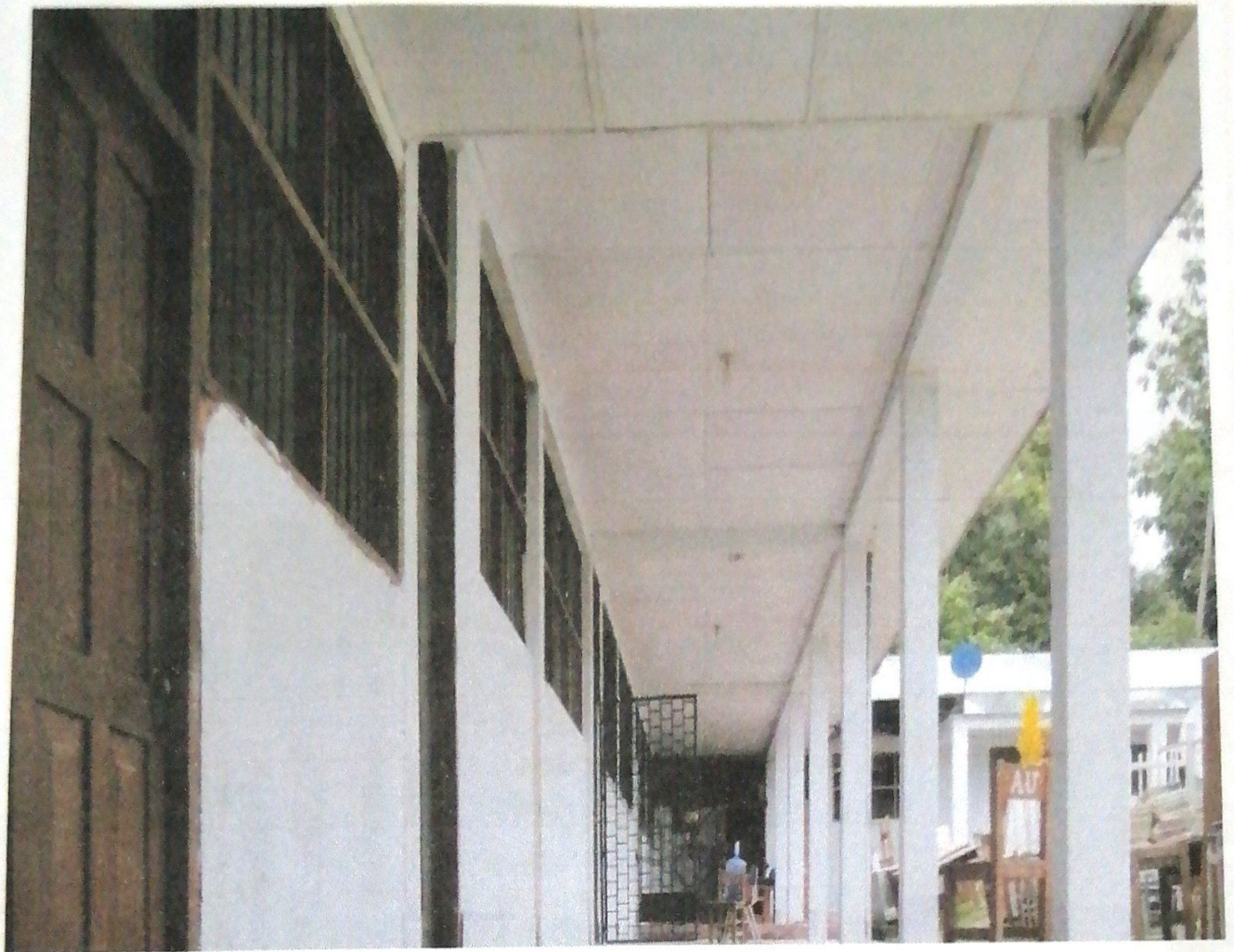
Pabellón de las aulas funcionales
