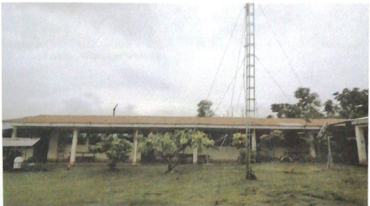
Pabellón de las aulas funcionales
