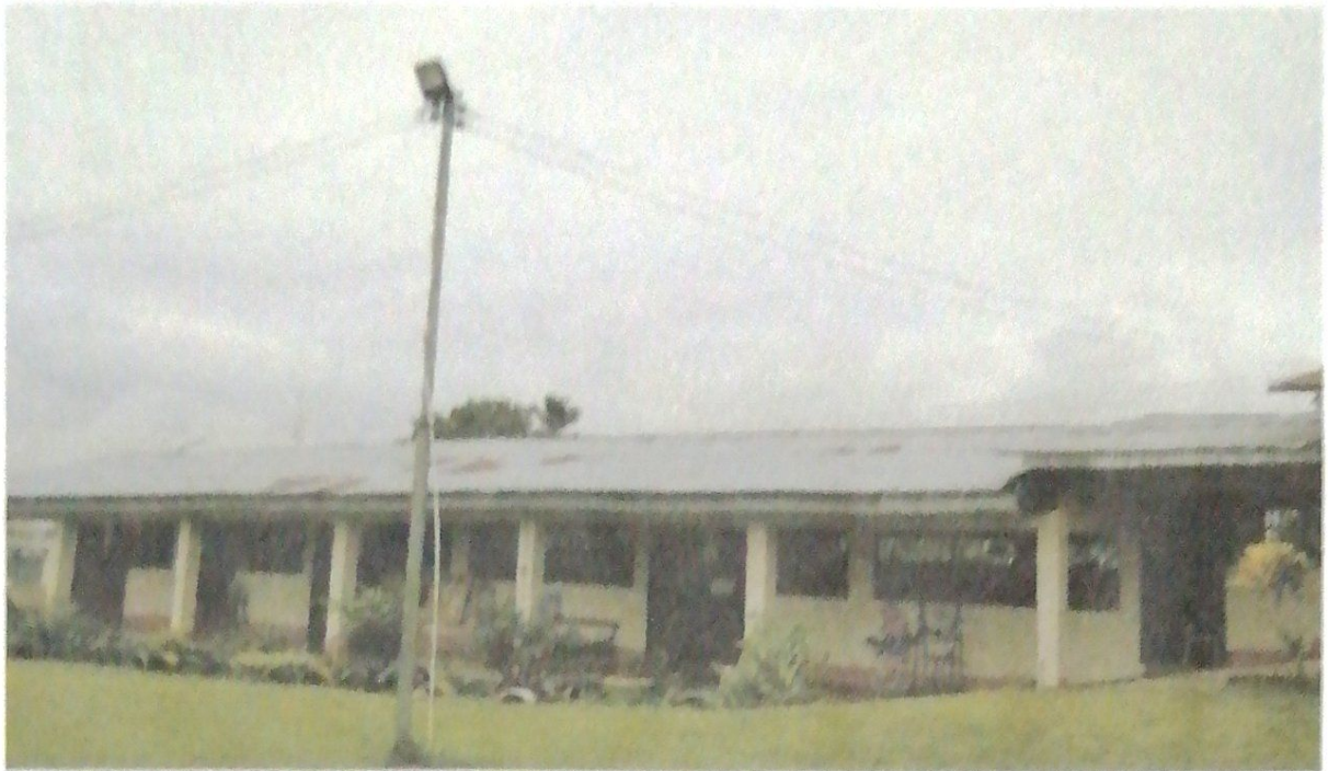
Pabellón de las aulas funcionales.
