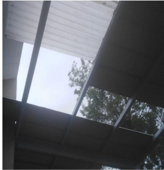
TECHO DEL PABELLÓN DEL NIVEL INICIAL, HUNDIDO PERMITIENDO GOTERAS
